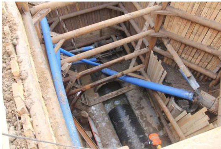
Рис. 4. Санация канализационного коллектора с применением спиральновитой трубы
