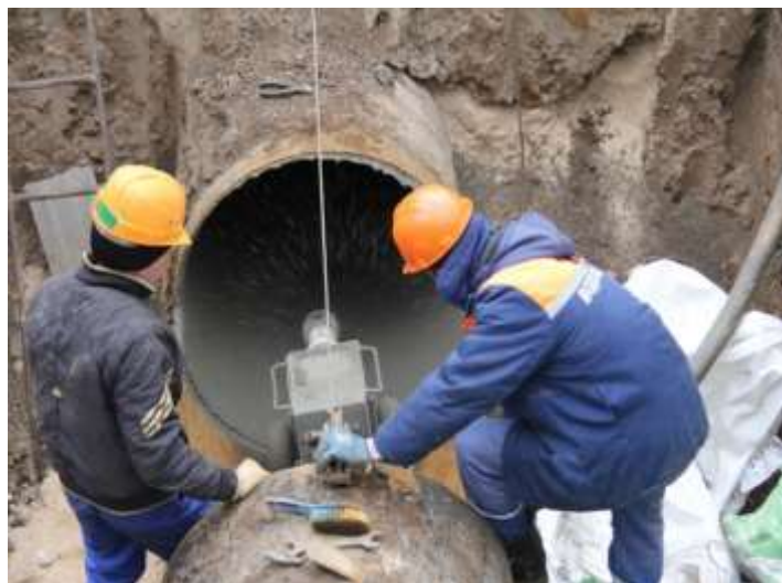
Рис. 3. Нанесение цементно-песчаного покрытия на внутреннюю поверхность водовода
