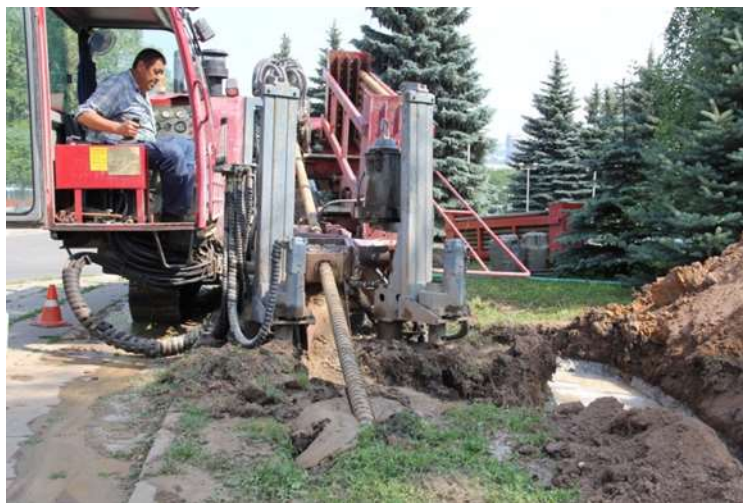
Рис. 1. Прокладка сетей методом горизонтально-направленного бурения
